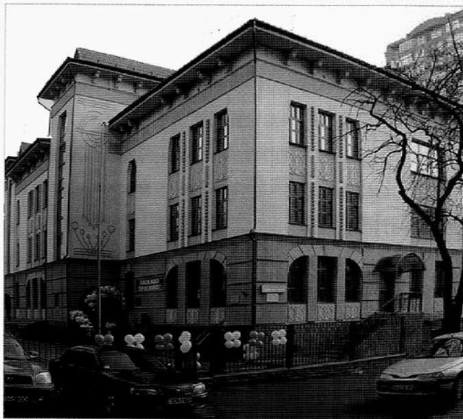
Будівля нового дитячого садочка для маленьких киян
