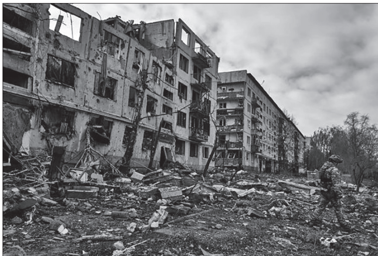
Зруйнований Бахмут — все, що залишилося від у минулому квітучого міста. У відкритому доступі
