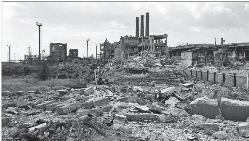
Маріуполь. Зруйнований завод «Азовсталь». Фото УНІАН
