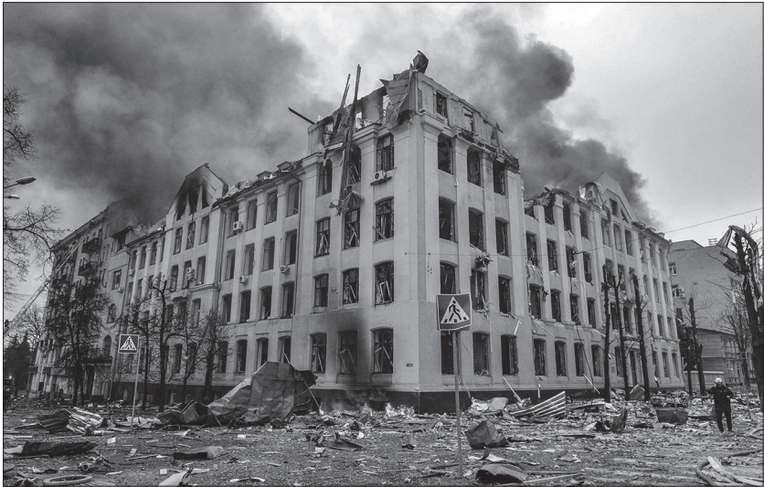
Будівля економічного факультету Харківського національного університету імені Каразіна, що постраждала від обстрілу з боку Росії 2 березня 2022 року. Фото: SergeyBobok / AFP via Getty Images
